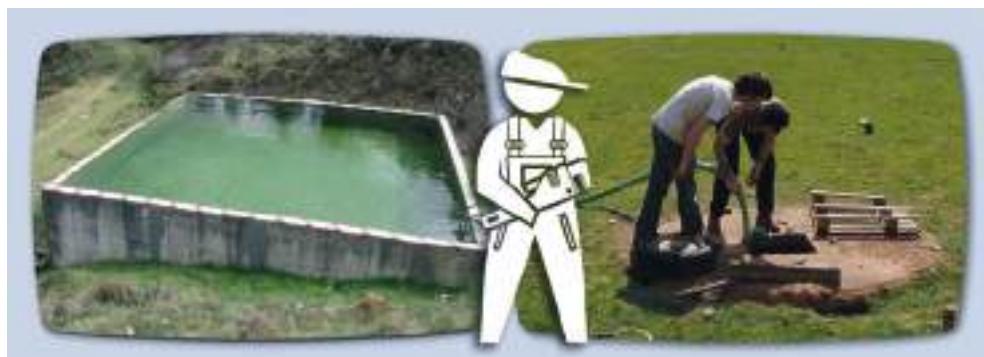
Fig. 15 Verificação de pontos de abastecimento de água.
